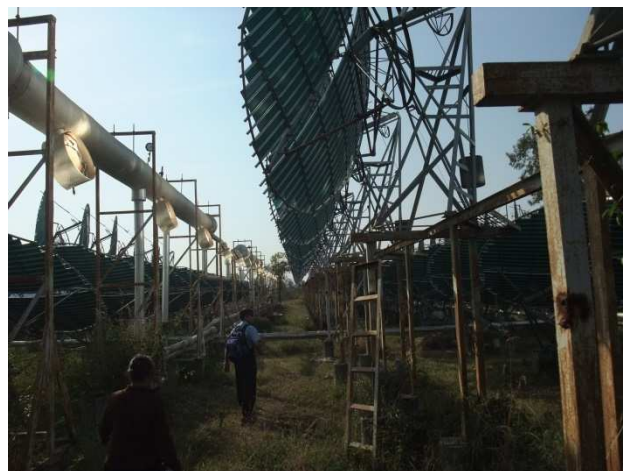
写真1 Muni Seva AshramのScheffler Dish型集光システムの反射鏡(右)と集熱部(左)
