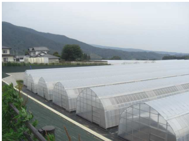
写真1：民家の間近に建設されている
