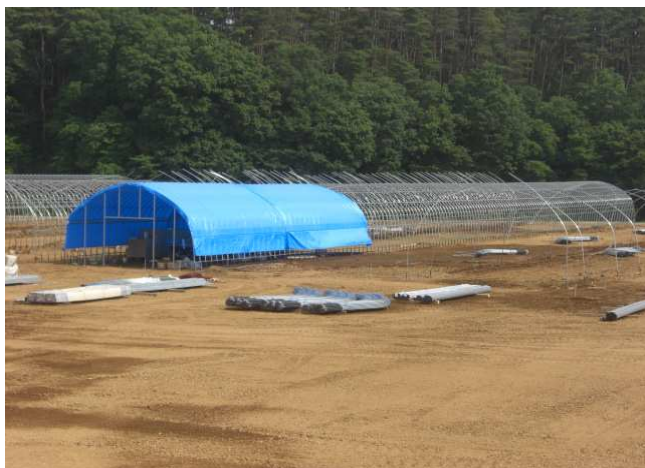
写真2：建設中のベビーリーフハウス
