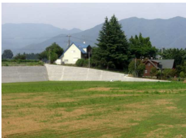
写真3：八ヶ岳南麓の斜面も削り取られ平坦に
