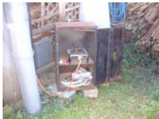
発生したメタンガスはゴムホースで台所や風呂、温水器などに引いて使用する
