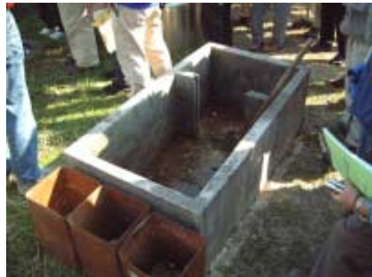
バイオガス発生槽の投入口。家畜の糞や生ゴミなどを入れる。臭いはほとんどない
