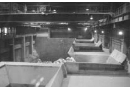
写真3：左がごみバンカ（貯蔵施設）。右に並んでいるホッパーにごみを投入して燃焼します。
