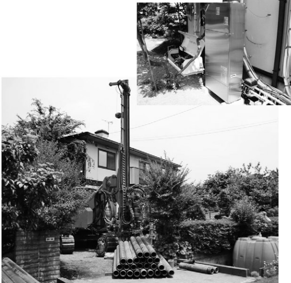
群馬県の一般住宅(既築)への導入工事
