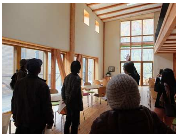
天窓や窓面を広くすることで照明の使用を低減
