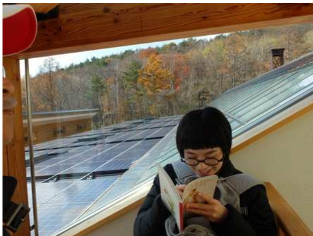
左が太陽光発電パネル、右が集熱パネル
