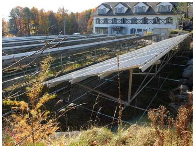
パネルの架台も簡易で強風などでの被害が心配
